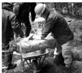
【写真15】搬出作業
