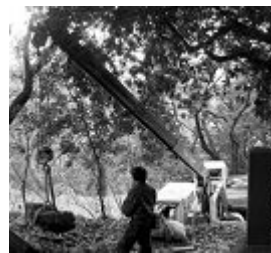
【写真16】設置作業
